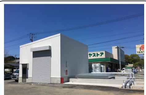
木質チップボイラー施設
